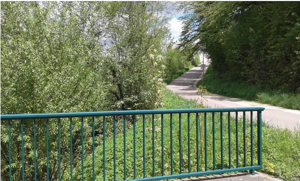
Abb.16: Brücke über den Krettenbach, Weidengehölze und nitrophile Krautschicht, Wirtschaftsweg
