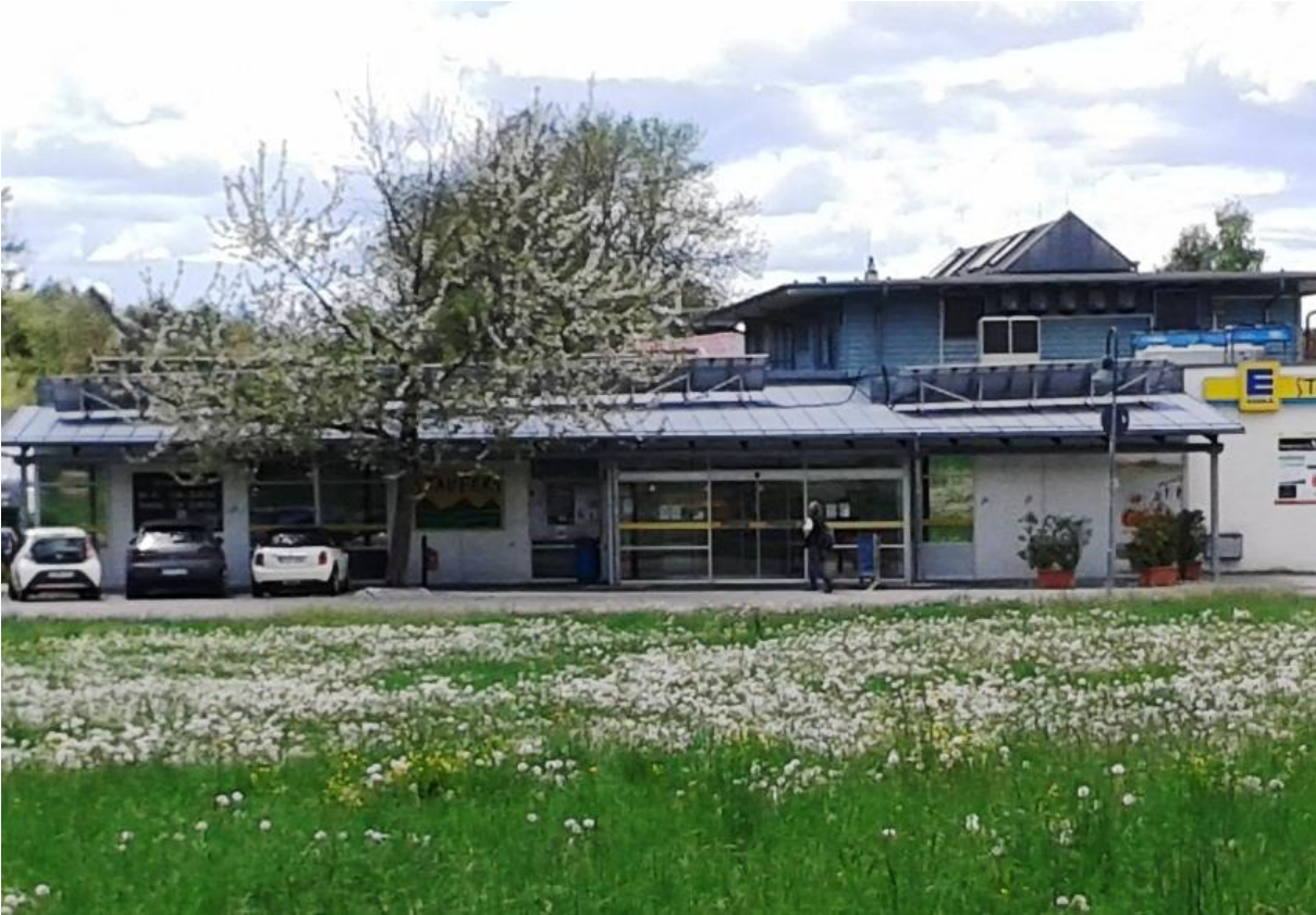
Abb.4: Bestehendes Marktgebäude mit Kirschbaum vor dem Eingangsbereich
