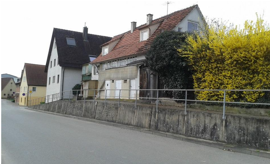
Abbildung 4: Vorhandene Bebauung an der Wunnensteinstraße
