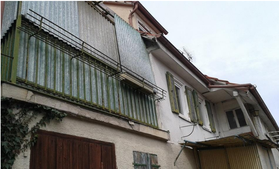
Abbildung 12: Fassade eines älteren Gebäudes mit Möglichkeiten für Gebäudebrütende Vogelarten und Fledermäuse
