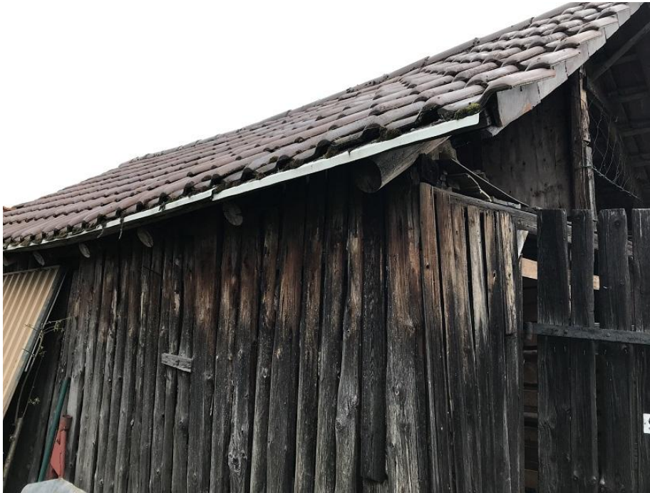
Abbildung 18: Der Holzschuppen eignet sich von seiner Konstruktion und den vorhandenen Einflugmöglichkeiten gut als Tagesversteck für Fledermäuse, ist allerdings nicht prädatorensicher
