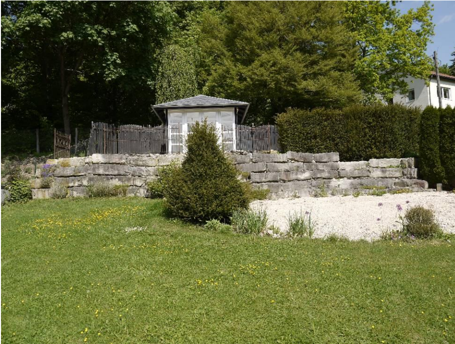
Abb. 4: Blick auf die nach Südosten ausgerichtete Natursteinmauer
