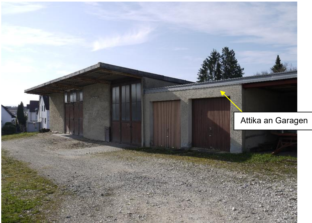
Abb. 6: Lagerhalle mit Garage
